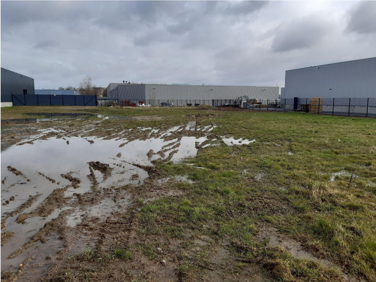
Figuur 10 Voorkom ontstaan van oppervlaktewater door werkzaamheden. Hier is door rijsporen oppervlaktewater ontstaan waar rugstreepad zich kan vestigen.
